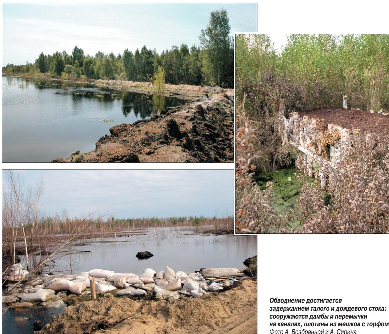
**Обводнение достигается задержанием талого и дождевого стока: сооружаются дамбы и перемычки на каналах, плотины из мешков с торфом.**
